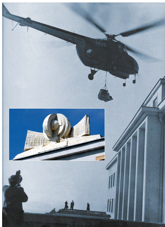
Obr. 2 Plastika zeměkoule na střeše budovy Geofyzikálního ústavu. Plastika zeměkoule je zhotovena z pískovce a váží 900 kg. Na střechu budovy ji po částech přemístil vrtulník 3. prosince 1958. Plastika byla zhotovena v ateliérech Uměleckých řemesel kolektivu sochaře J. Zeleného na návrh akademického sochaře J. Kulhánka. Sádrový model plastiky je vystaven v předšálí přednáškového sálu ústavu. Foto: Archiv GFÚ AV ČR
